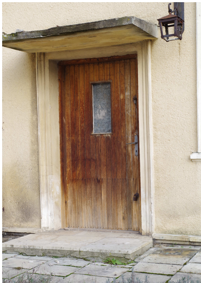
Fot. Nr 3 W elewacji zachodniej daszek do remontu , lampa i drzwi do wymiany , spocznik wyłożony płytkami dolomitowym do remontu
